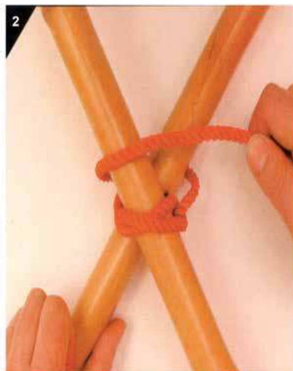
ÉTAPE DEUX. FAIRE UN TOUR AUTOUR DES DEUX PERCHES CROISÉES, EN SERRANT LE NŒUD DE BOIS.
